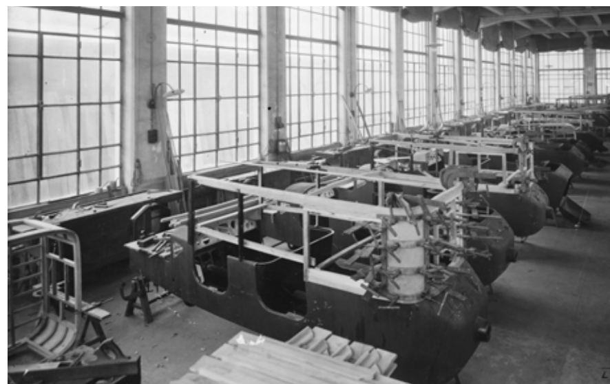
Foto 23: Assemblaggio del "ballon" per la torpedo Lambda
